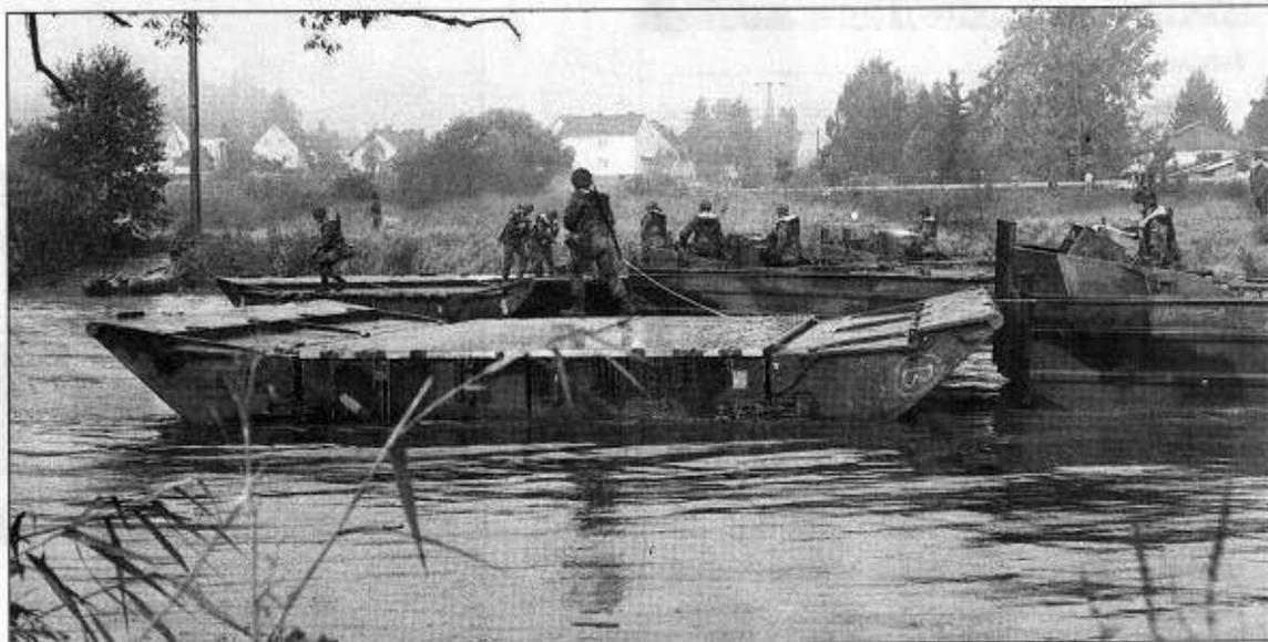
Die einzelnen Teile der Brücke werden zu einer stabilen Verbindung zusammengesetzt.
